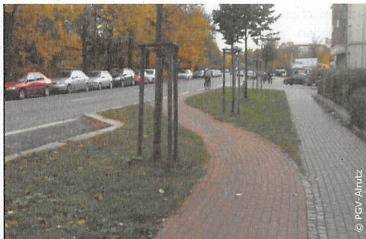
Abb. 5-15: Radverkehr wird im Vorfeld des Knotens an den Fahrbahnrand und damit ins Sichtfeld des Kfz-Verkehrs geführt
