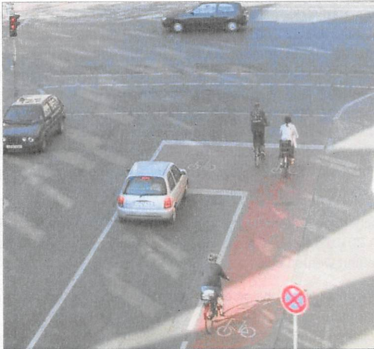
Abb. 5-20: Aufgeweiteter Radaufstellstreifen (ARAS) (Hannover)
