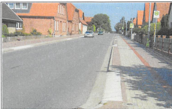
Abb. 5-3: Grundstückszufahrten mit Rampenstein (Soltau)
