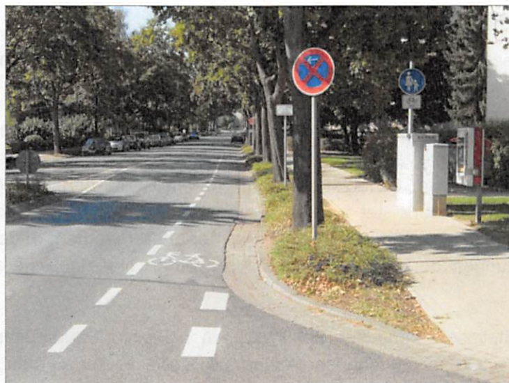
Abb. 5-12: Kombination von Schutzstreifen mit Gehweg, Radverkehr frei (Hameln)
