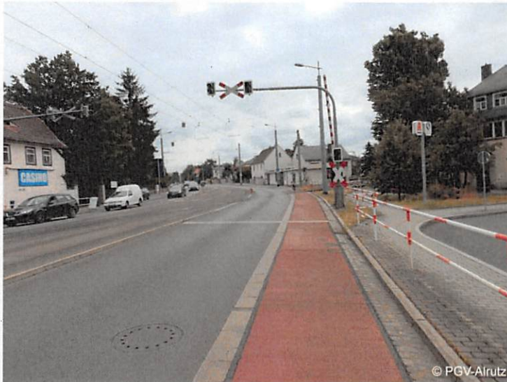
Abb. 5-10: Radfahrstreifen (Radebeul, Meißner Straße)
