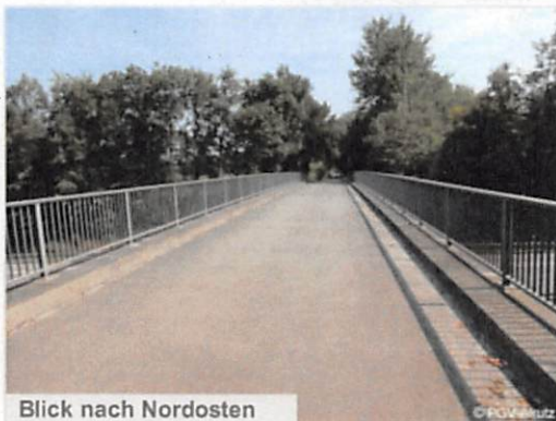
Blick nach Nordosten
