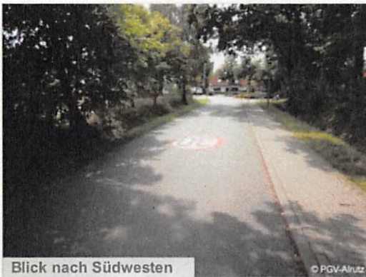
Blick nach Südwesten
