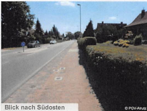
Blick nach Südosten
