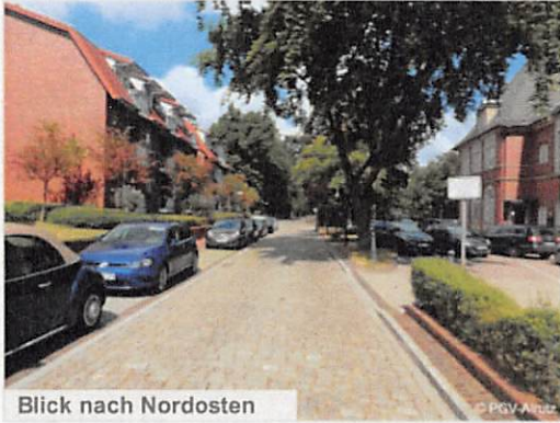
Blick nach Nordosten
