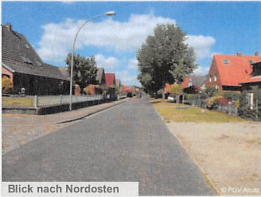
Blick nach Nordosten
