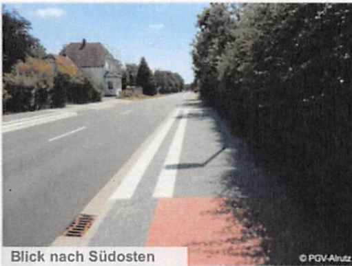
Blick nach Südosten
